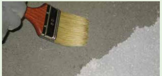
**IMPERMEABILIZZAZIONE DEL GIUNTO DI FRAZIONAMENTO
