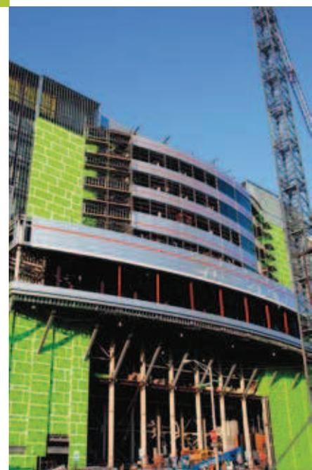
**SECUROCK®** è una lastra dai molteplici impieghi per realizzare rivestimenti esterni, di pareti perimetrali e strutture, tamponamenti a secco, pareti con rivestimento a cappotto, controsoffitti per piani pilotis ed elementi architettonici.
